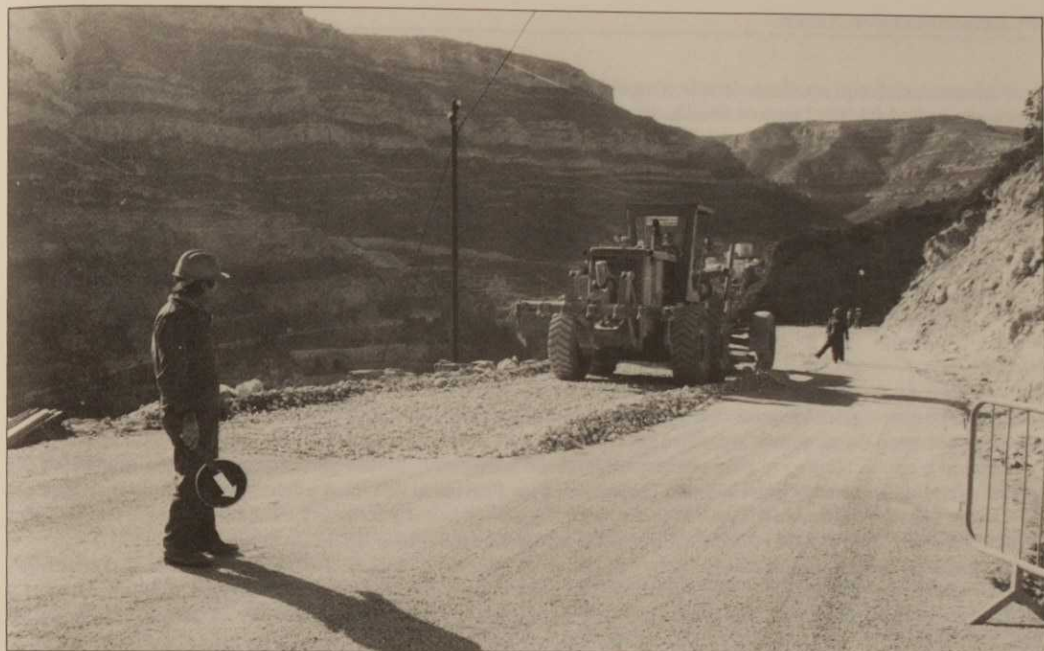
Obras de infraestructura vial en las carreteras valencianas.
